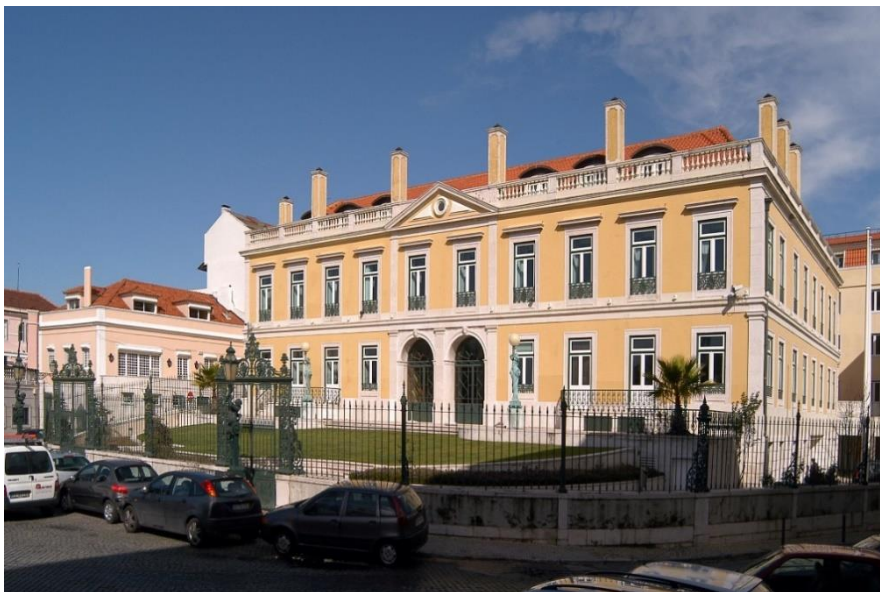
Figura 4 - Edifício sede da Associação Nacional das Farmácias, localizado na Rua Marechal Saldanha, 1, 1249-069 Lisboa. Fonte: Banco de Imagens do Museu da Farmácia.
