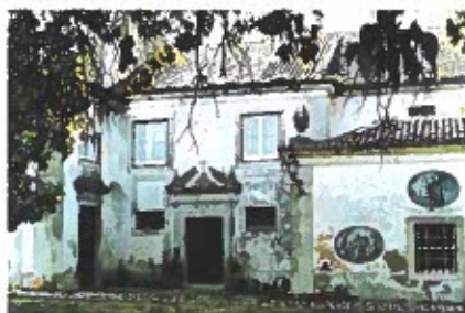
Quinta do Calhariz (fachada posterior/capela)
