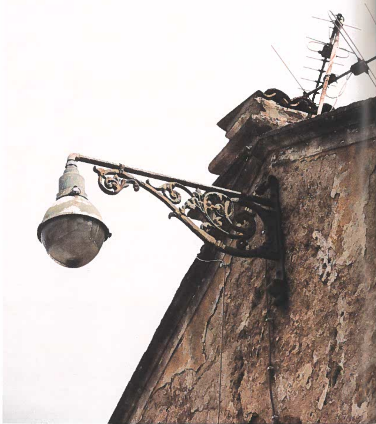
18 – Fotografia actual da Praça da Viscondessa dos Olivais; Candeeiro de rua (consola).
