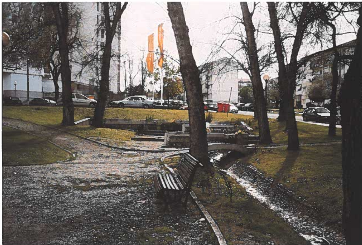
29 – Fotografia actual da Zona Verde tangente à Rua Cidade da Beira; Bancos modelo 17C.
