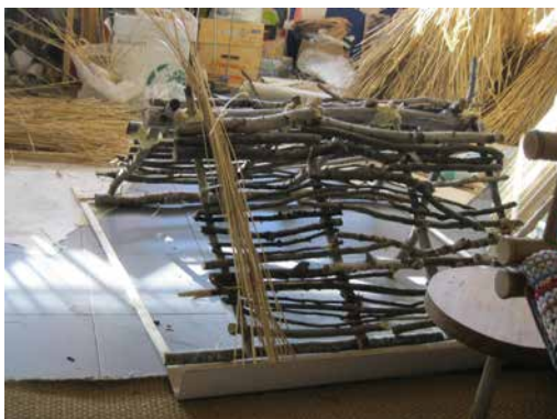
Fig. 58 Colocação dos troncos ( ripado de paus ) que irá formar a estrutura que sustém cobertura em colmo.
