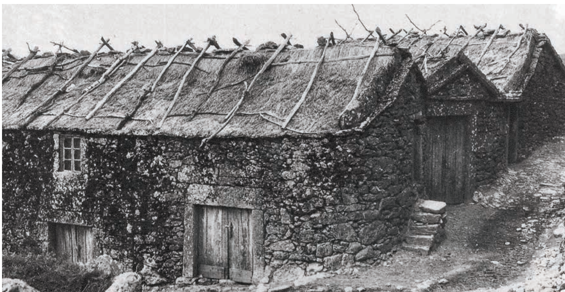
Fig. 41 Casas com cobertura em colmo com travessos em tesoura , Castro Laboreiro
