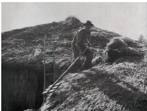
Fig. 35 Assentamento do colmo com colmadeira, Celorico de Basto.
