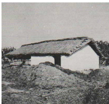
Fig. 5 Casa com cobertura em colmo em Samora Correia, Portugal.
