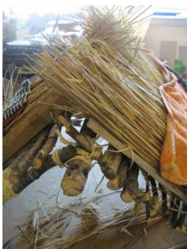
Fig. 62 Colocação das camadas seguintes de colmo.
