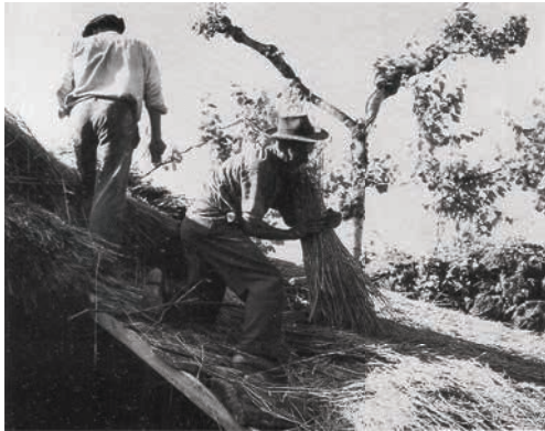
Fig. 32 Colocação do colmo, Celorico de Basto.
