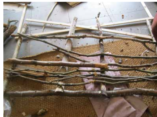
Fig. 57 inicia-se a construção da estrutura em madeira, que irá sustentar a cobertura (colocação dos varedos / caibros , troncos que irão compor cada água do telhado).
