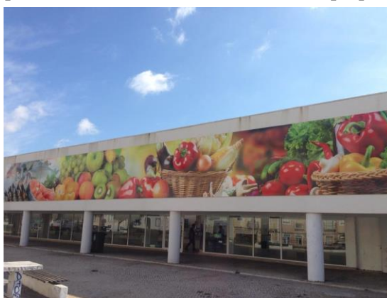
Figura 20 - Fachada do Mercado dos Sapadores
