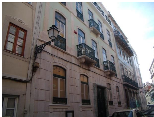
Figura 25 - Fachada da Escola Luísa Ducla Soares
