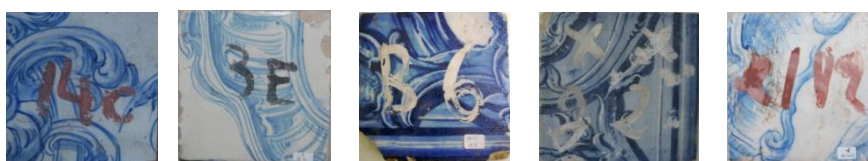
Fig.134,135,136,137,138-Azulejos com marcas de levantamento no vidrado.
