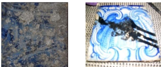
Fig.47,48- Azulejos com cimento e tintas
