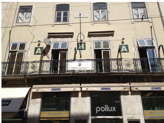
Foto 1 - Rua dos Fanqueiros 278-282, fachada (pormenor).
