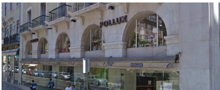
Foto 9 - Rua dos Fanqueiros 270-276 (Pollux), 2013 (Google maps).
