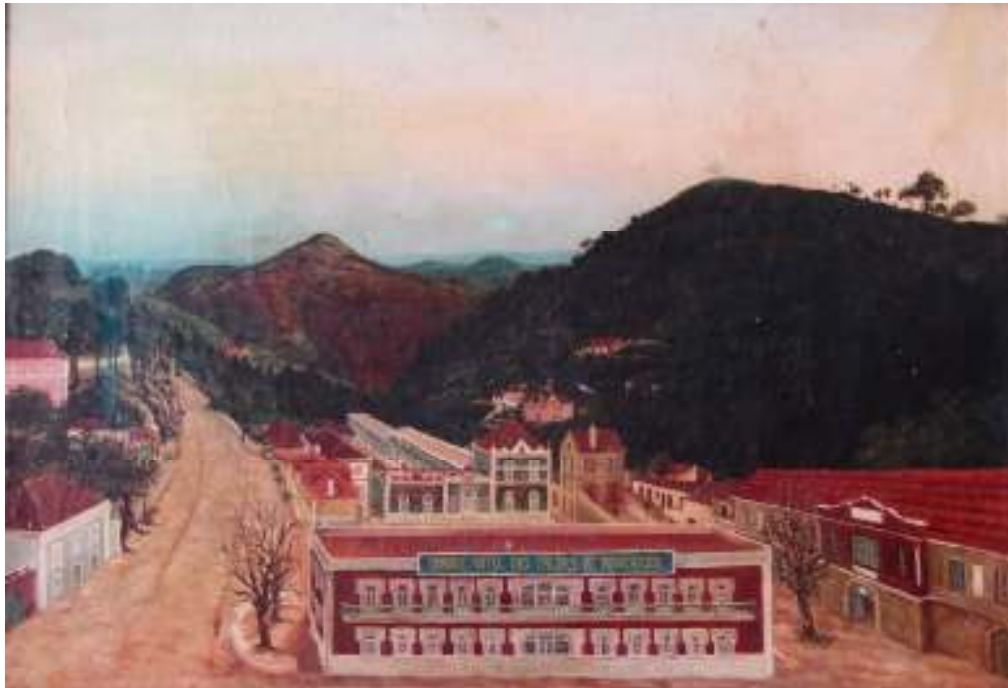
Fig.61- Pintura de Ângelo de Lima executada em 1899 por encomenda de João Bentes Castel-Branco, com a representação do núcleo edificado das Caldas de Monchique (79cm x 54cm) (Propr. STM; Foto: Ana Pinto, 2012)
