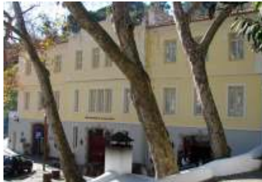
Fig.33: Aspecto actual da Hospedaria Nova, hoje designada por Apartamentos D. Francisco. Em 1931 foi-lhe adicionado um piso superior, e nessa intervenção, a platibanda sofreu alterações. (Foto: Ana Pinto, 2008)
