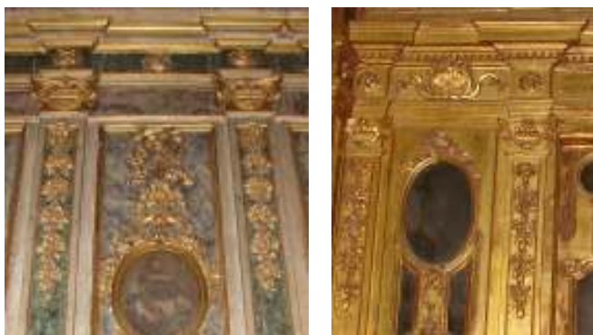
Figs.83 e 84- Pormenor da parede da Tribuna das Freiras, na Estrela. Aspecto do retábulo da capela de S. João de Deus e de Santa Teresa. De notar a semelhança entre o tipo de entablamento, as molduras com laços, os capitéis jónicos com festões e os pendões florais em ambas as figuras.
