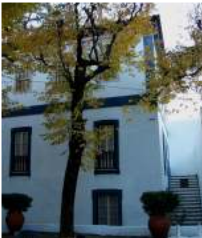
Fig.25- Aspecto actual da fachada do chamado Palacete. (Foto: Ana Pinto, 2012)
