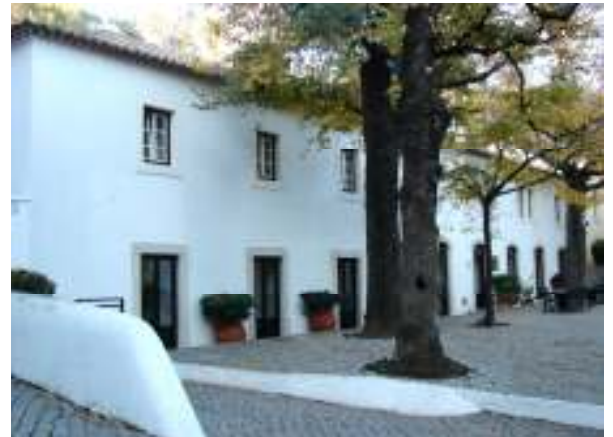
Fig.24- Aspecto actual da fachada da Hospedaria Velha. A estrutura inicial edificada em 1692 correspondia à parte média do edifício, que era térreo. Sofreu no século XIX ampliações para os flancos Poente e Nascente, tendo-lhe sido acrescentado um piso. (Foto: Ana Pinto)
