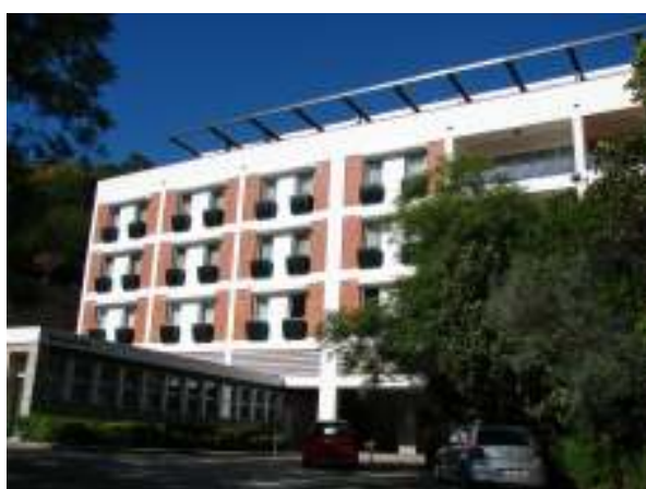
Fig.76- Aspecto actual do edifício, motando-se as reformulações feitas posteriormente na sua adaptação a unidade hoteleira, com a divisão dos janelões e a colocação de floreiras. (Foto: Ana Pinto, 2012)
