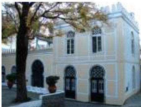
Fig.35- Aspecto actual da fachada Norte do Club, iniciado em 1898 e concluído em 1902. Em postais da transição para o século XIX verifica-se que a traça não foi alvo de alterações significativas. O edifício passou a ser conhecido posteriormente como Casino. (Foto: Ana Pinto, 2008)
