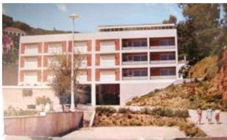
Fig.75- Aspecto da fachada principal (Sul) do Hospital Termal riscado por Formosinho Sanchez, atravessado no piso térreo pelo Balneário (num postal da década de 1970?). (Propr.: Delmira Fortunato Marques)
