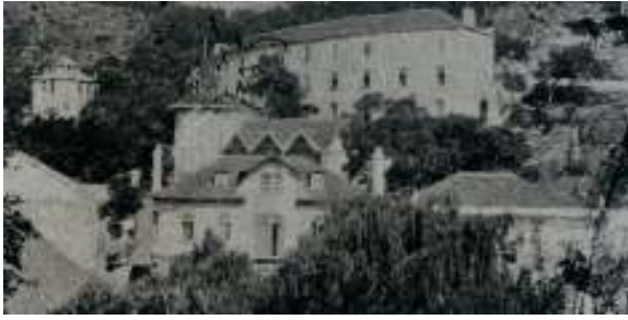
Fig.43: Detalhe de um postal da primeira metade do século XX. Em primeiro plano, a parte superior da fachada Poente do Hotel Central, com águas furtadas e mansarda central, entretanto retiradas. Atrás, o chalet construído por Gregório Mascarenhas, e por
