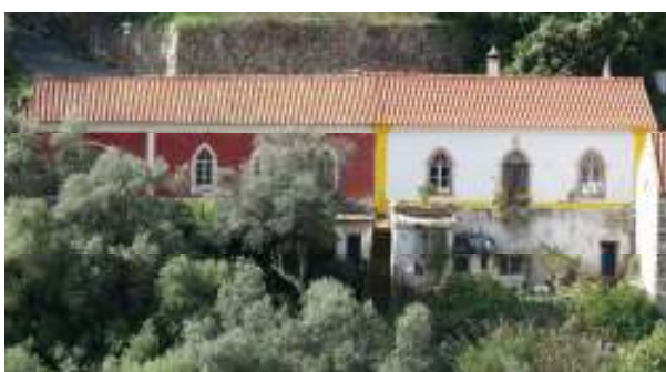
Fig.49- Habitações geminadas no vale das Caldas de Monchique, com os vãos em arco ogival.
