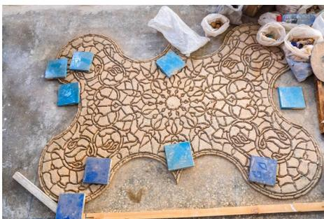
Figura 8. Coloca las fichas en la cara como un rompecabezas. Fotografías del Autor.
