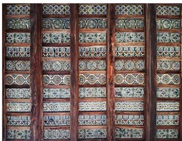
**Figura 2:** Teto de vigas mestras e secundárias revestido com placas de teto. Claustro do piso térreo do antigo Convento de Santa Clara (c. 1400, Sevilha). Fonte: própria © Ana Cláudia Sousa, setembro 2020
