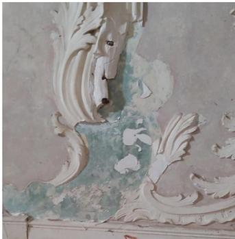
Figura 6: Pormenor de parede com destacamento de gesso deixando transparecer a cor original das paredes. Fonte: própria.
