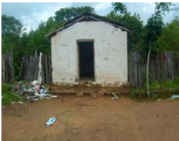
Figura 2: Capela que abriga a Cova da Tia. Fonte própria.
