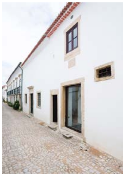
Figura 3. Sinagoga de Tomar (fachada); Créditos fotográficos – João Almeida
