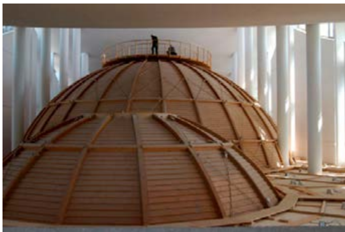
Figura 2. Construção das estruturas de madeira dentro do espaço existente (Dettagli Architettura, 2010).
