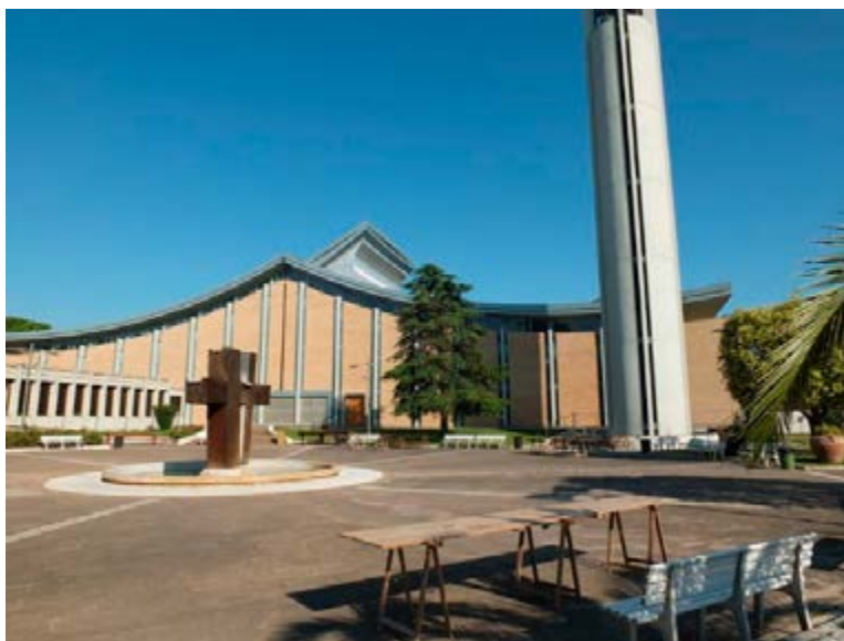
Figura 1. Edificação existente da igreja (OFM Cap, 2013).
