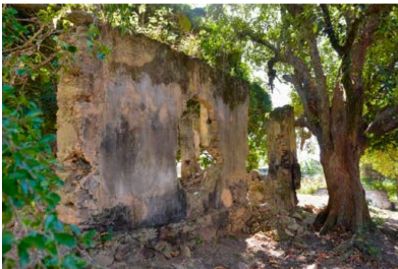
Figura 3. Vista da fachada lateral esquerda (2020). Fonte: própria.
