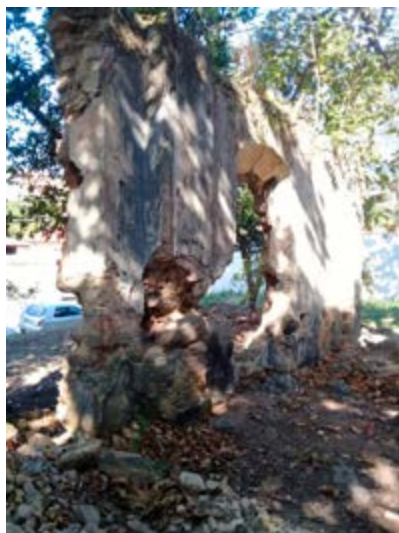
Figura 4. Detalhe de verga remanescente A(2020). Fonte: própria.
