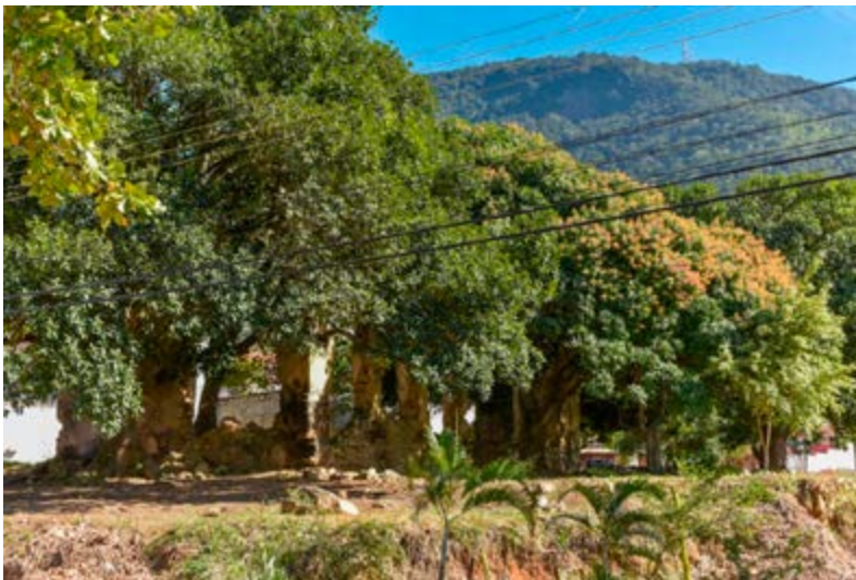
Figura 1. Vista das ruínas pela rua Antonio Bernardes Tavares esquina com Rua Sergipe (2020).Fonte: própria.
