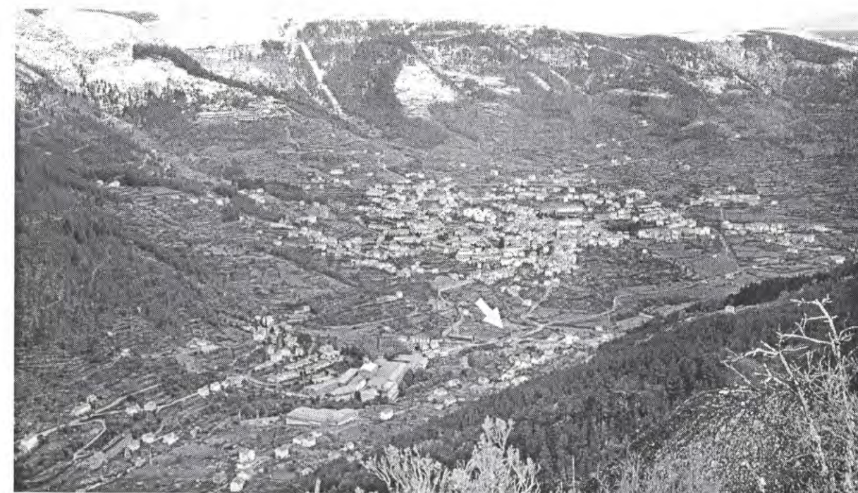
Figura 3.48 – Localização do corte da Ponte de Santo António na bacia de Manteigas (vista para noroeste desde o Sítio das Pessoltas).
