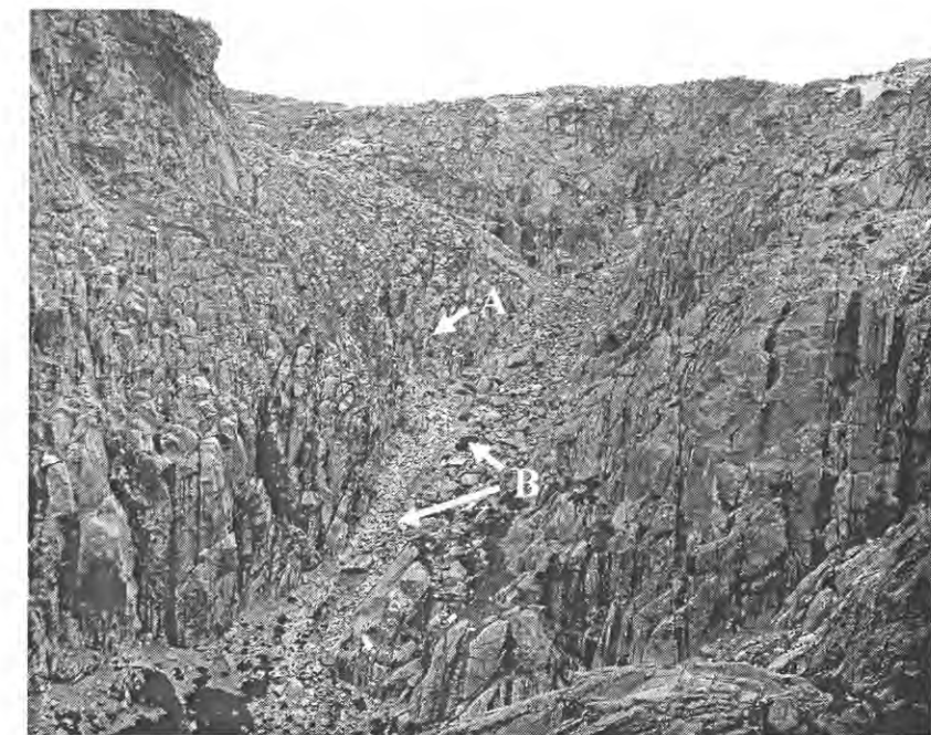
Figura 9.56 – Desabamento ocorrido em 2002 no Corredor das Roseiras (base da vertente noroeste do Cântaro Magro). A – Cicatriz do desabamento; B – Blocos desabados.
