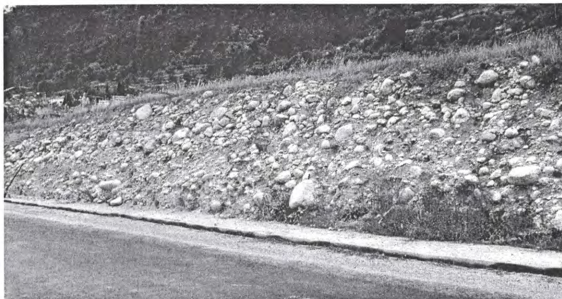
Figura 3.49 – Aspecto geral do corte no terraço fluvioglaciário da Ponte de Santo António (Manteigas) em 1995.
