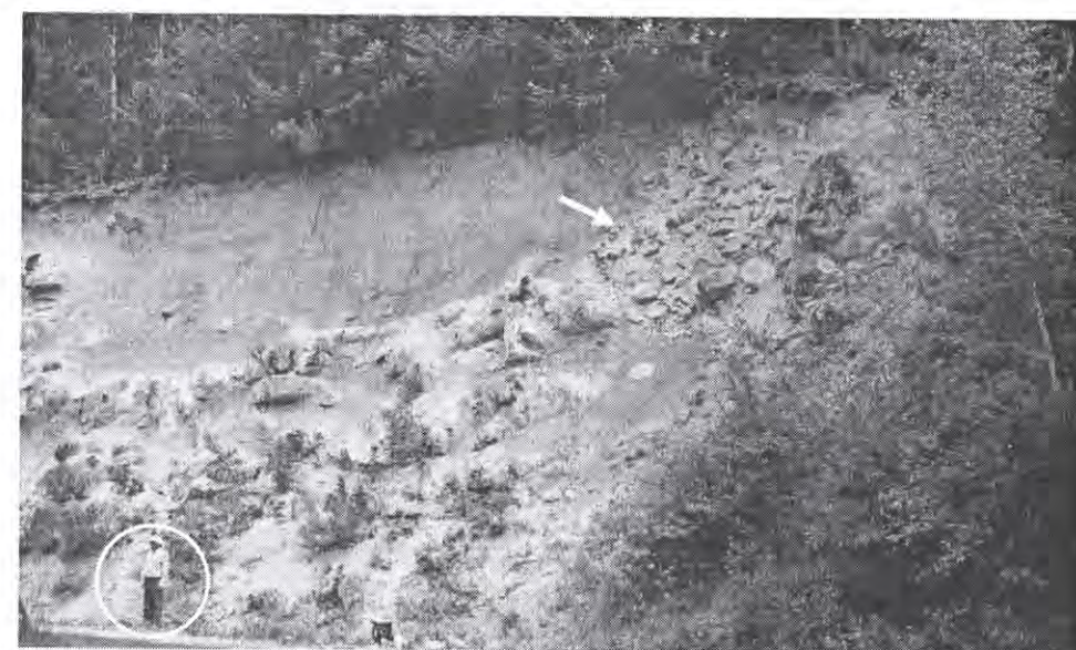
Figura 6.22 – Corte do cruzamento do campo de futebol. Aflora um saprólito granítico evidenciando uma alteração profunda. Na parte superior direita, é possível ver o depósito de material grosseiro embutido no saprólito.
