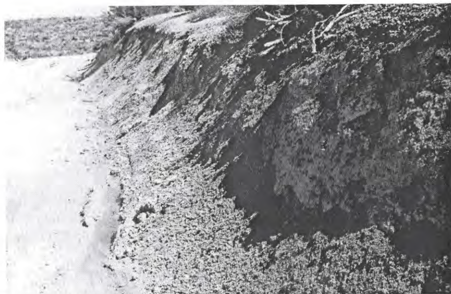
Figura 9.14 – Microtalude em corte no estradão da Malhada Alta (1400 m).
