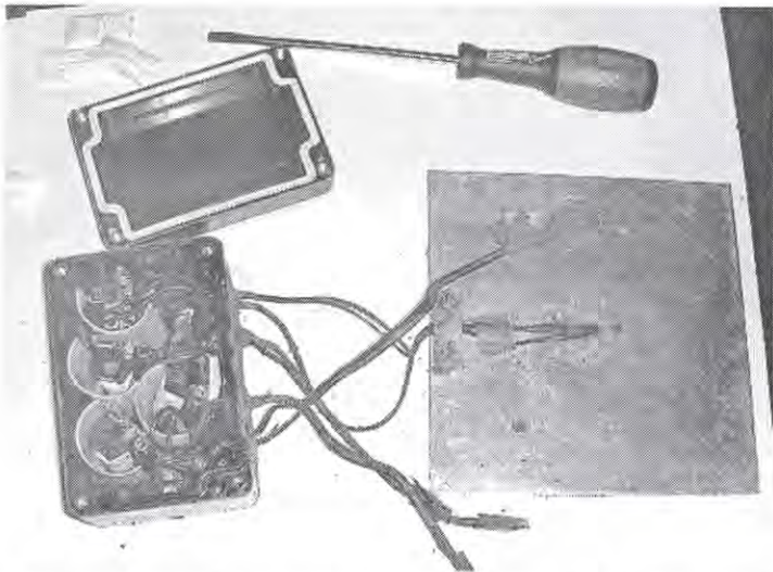
Figura 10.5 – Sistema de monitorização das temperaturas do solo. Do lado esquerdo encontra-se a caixa estanque, com os 4 data loggers . Do lado direito são visíveis os 4 termistores, dos quais, o que ficou em posição mais superficial, está embutido numa placa de alumínio com 15x15 cm.
