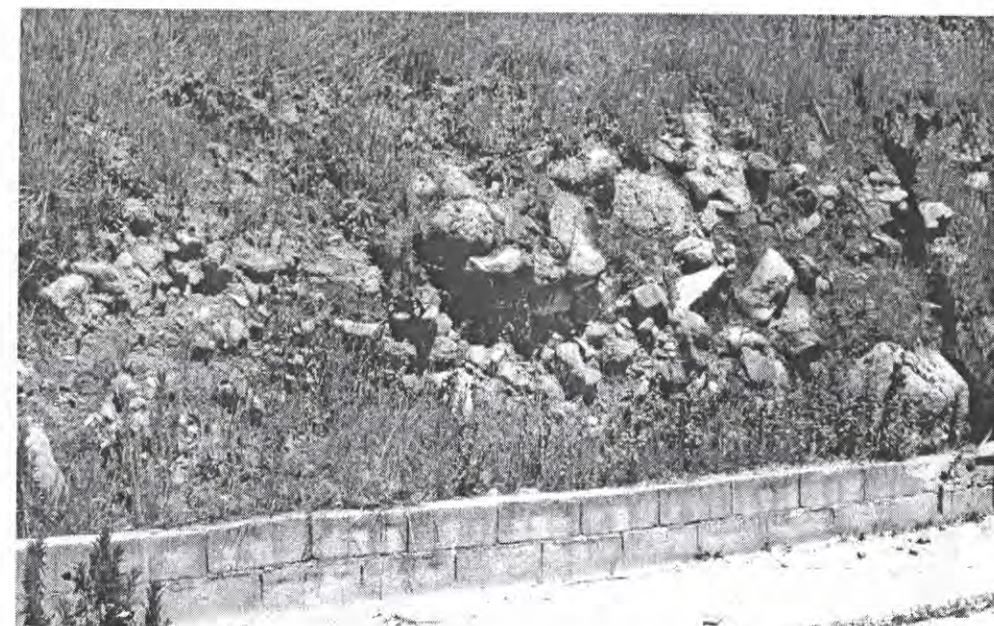
Figura 6.29 – Corte num depósito com origem em escoadas de detritos próximo do Ribeiro da Vila (Manteigas – 840 m).
