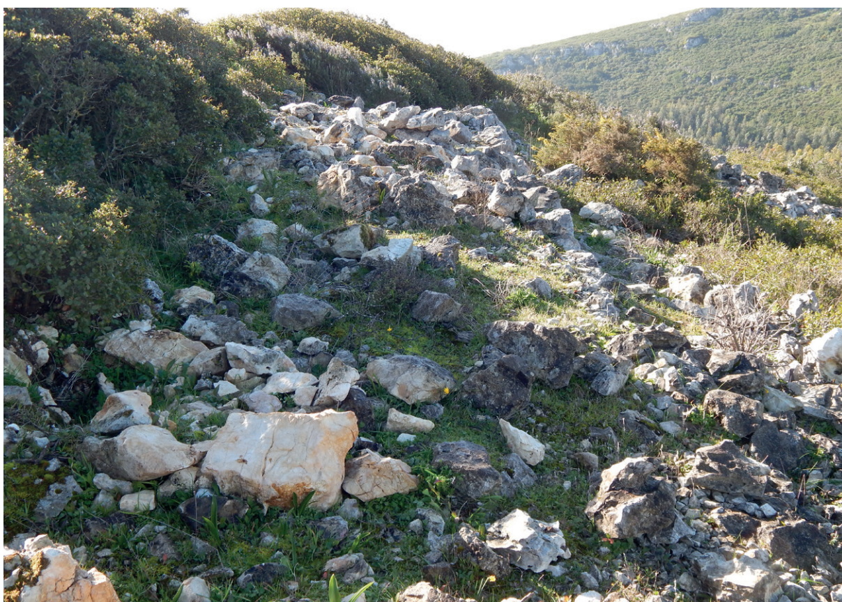
Figura 128 – Pormenor da muralha que rodeia o Castro de São Salvador.
