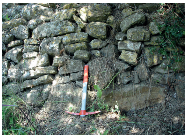
I.09 – Alçado da muralha que delimita a plataforma superior.
