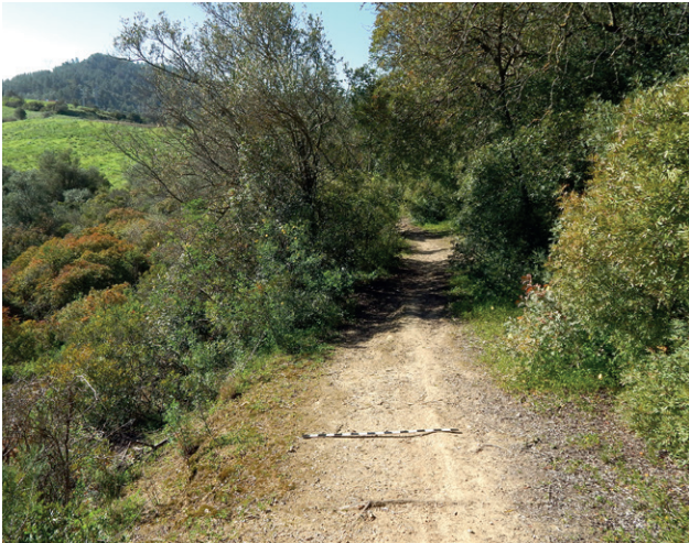
I.111 – Sondagem 9. Antes do início dos trabalhos, pormenor do caminho que ainda hoje existe sobre a muralha.
