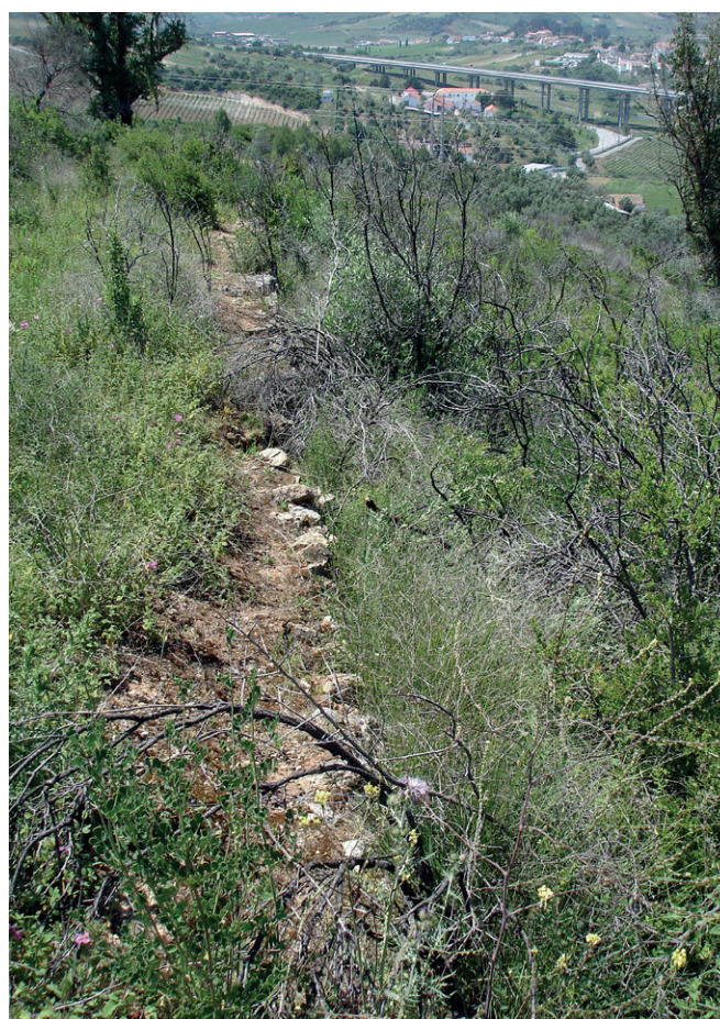
I.10 – Pormenor de um dos taludes da muralha.
