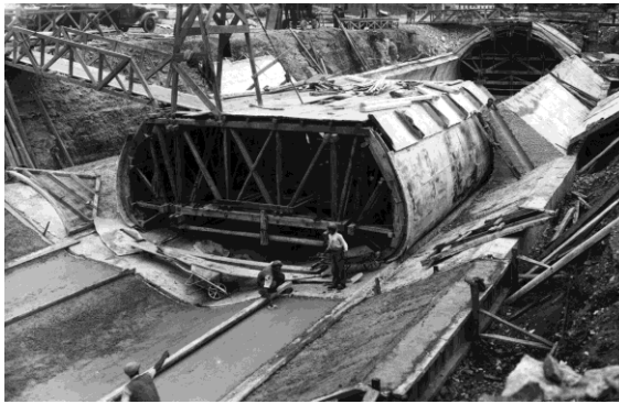
Figura 23: Caneiro de Alcântara, obras de cobertura da ribeira de Alcântara junto da Ponte Nova. 1945 (Fonte: Arquivo Fotográfico da CML).
