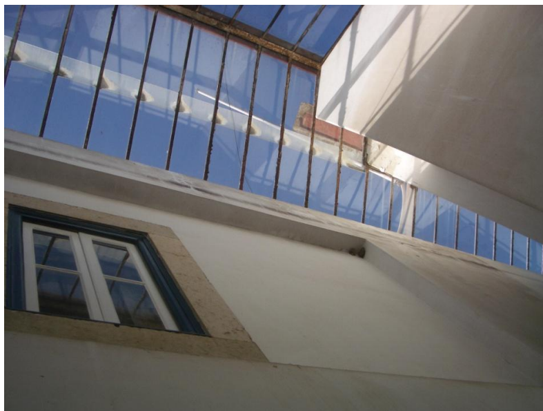
Fig.3.32. Cobertura de vidro, realizada nos anos 60, na Ala do Séc. XVIII. Foto da Autora (2008).
