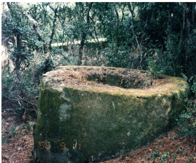
Fig.3.19. Chaminé da Mina da Quinta dos Marqueses de Fronteira e Alorna, antes da intervenção.
