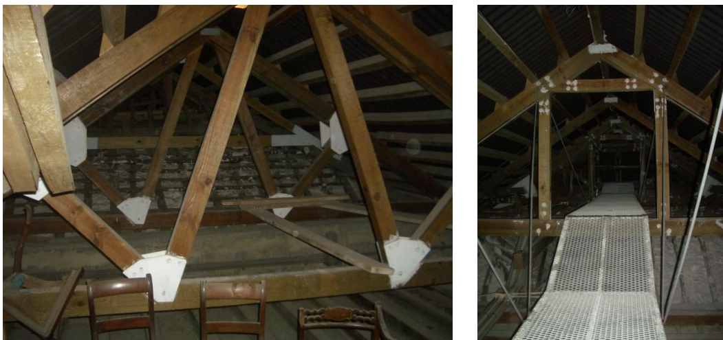
Fig.3.54. Cobertura da Sala de Estar e Quarto do Marquês. Vista para SW e para NE, respectivamente. Foto da Autora (2008).
