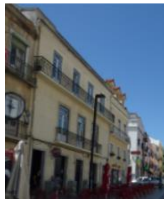
Figura n.º 27. Imagem da obra concluída.
