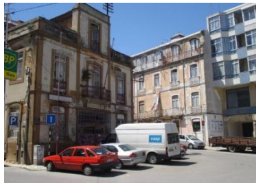
Figura n.º 43. Largo dos Bombeiros Voluntários. Fonte: Câmara Municipal de Almada
