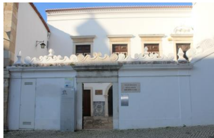
Figura n.º 79. Edifício da Casa do Corpo Santo. Fonte: Autora. Maio 2019
