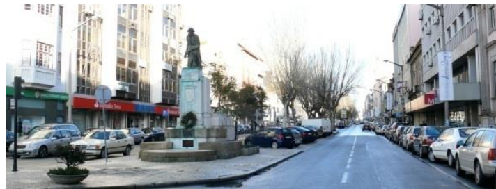
Figura n.º 122. Avenida Dr. Lourenço Peixinho. Antes da Intervenção.
