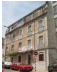
Figura n.º 11. Rua Elias Garcia n.º. 2 - 6 Antes da Intervenção
