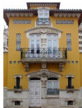
Figura n.º 116. Alçado Principal do Edifício da Residência do Arquiteto Silva Rocha. Fonte: Autora. Abril de 2022.
