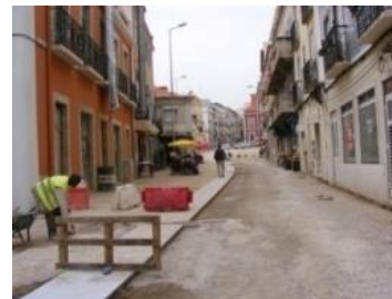
Figura n.º 25. Imagem de obras na Rua Cândido dos Reis.
