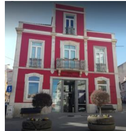
Figura n.º 44. Largo dos Bombeiros Voluntários. Fonte: Câmara Municipal de Almada
