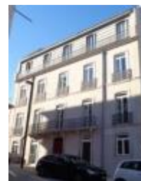
Figura n.º 42. Rua Elias Garcia n.º. 2 - 6 Depois da Intervenção.
