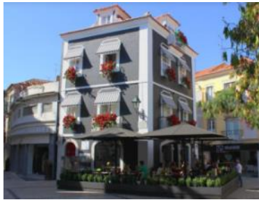
Figura n.º 82. Edifício do Restaurante “Sem horas” Fonte: Autora. Maio de 2019.
