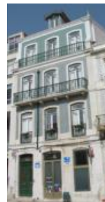
Figura n.º 40. Rua Cândido dos Reis n.º. 140-142 Depois da Intervenção
