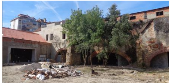
Figura n.º 58. Conjunto Industrial do Caramujo Romeira. Imagem do antes da obra (2016).
