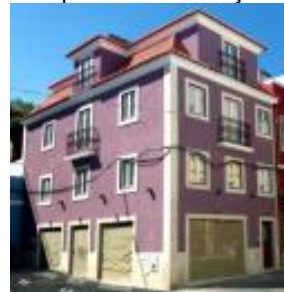
Figura n.º 36. Rua Cândido dos Reis n.º. 37-39 Depois da Intervenção.
