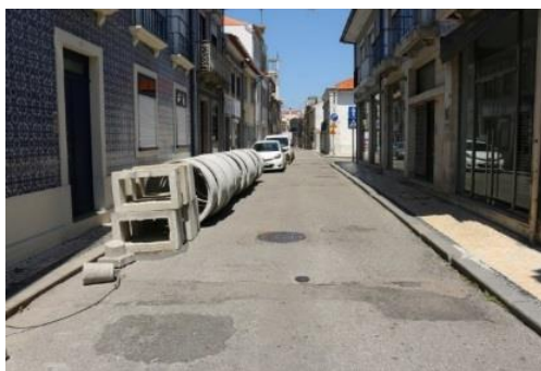
Figura n.º 127. Rua do Gravito e da Rua do Carmo. Antes da Intervenção. Fonte: REABILITAÇÃO DA RUA DO GRAVITO E DA RUA DO CARMO | Câmara Municipal de Aveiro (cm-aveiro.pt), visitada a 15 de março de 2022.
