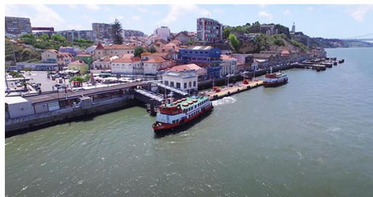
Figura n.º 53. Vista aérea sobre o Cais do Ginjal. fonte: imagem de drone feita pela autora.
