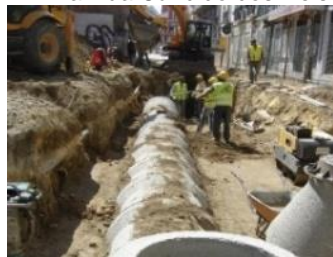
Figura n.º 24. Imagem de obras na Rua Cândido dos Reis.
