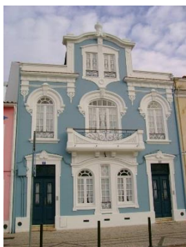
Figura n.º 115. Alçado Principal do Edifício do Rossio. Fonte: Autora. Abril de 2022.
