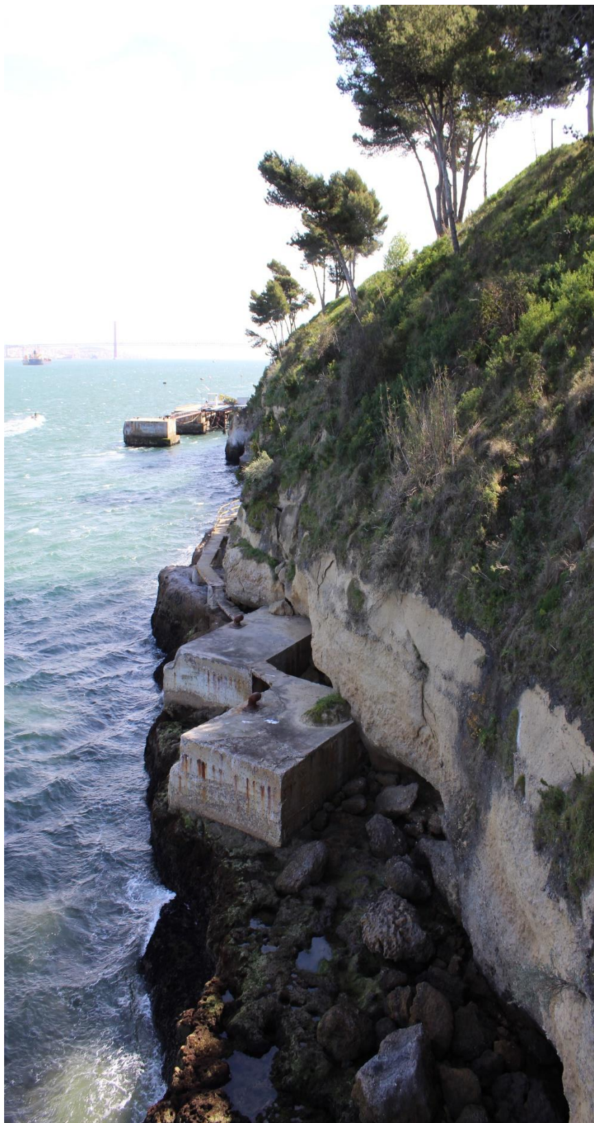
Fig.18. Vista do Percurso de Ronda sobre a encosta. Fotografia da autora. 2019.
