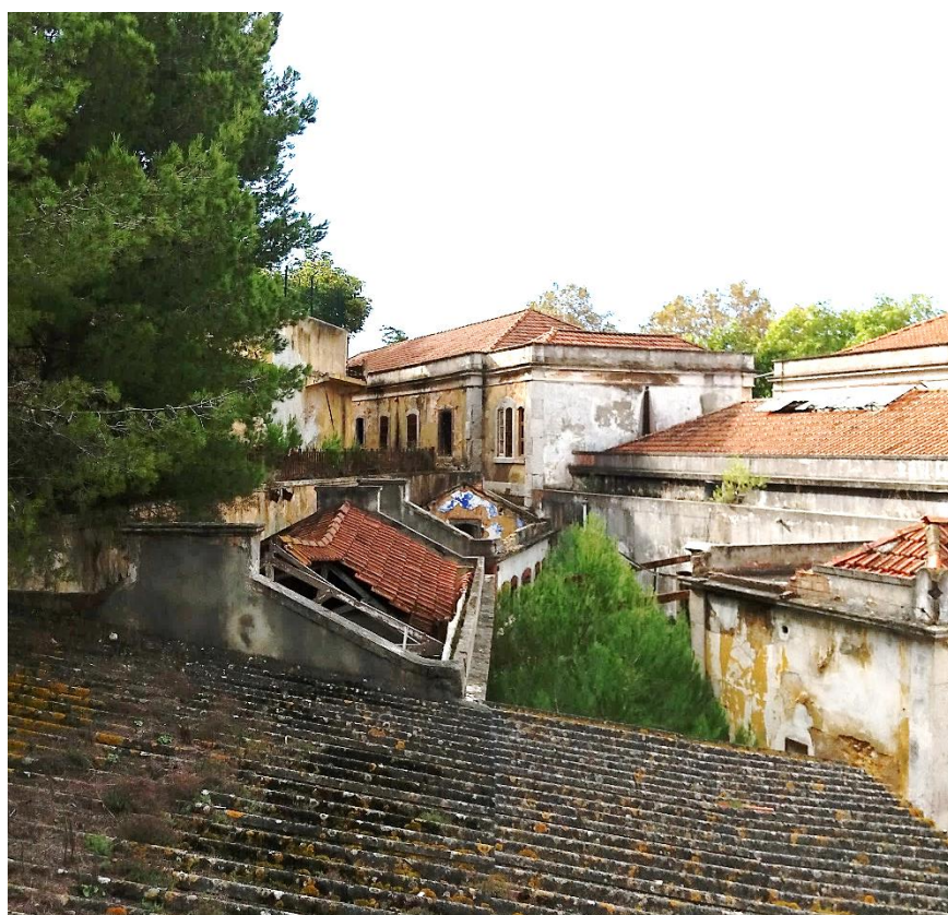
Coberturas dos anexos e do edifício 4. Vista a partir do edifício 5. Fotografia da autora. 2019.
