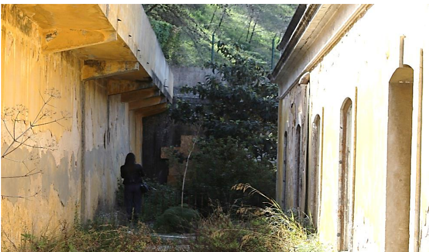
Plataforma acessível através do piso 1 do edifício 4. Fotografia da autora. 2019.
