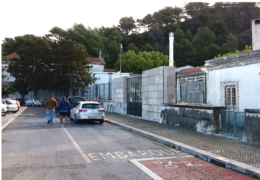
Muros que cercam o antigo Presídio. Fotografia da autora. 2019.
