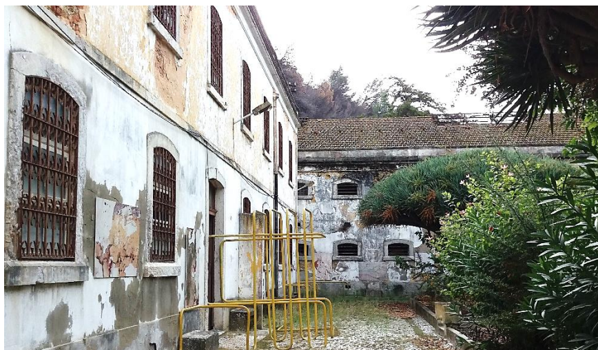
Perspetiva do edifício 4 com vista para sul. Fotografia da autora. 2019.
