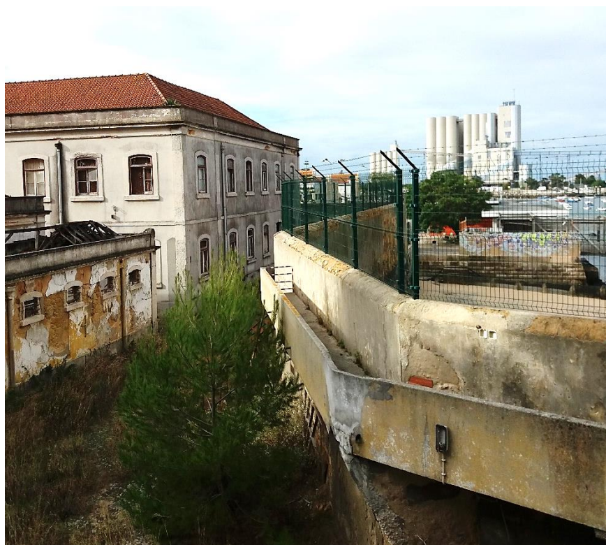
Vista a partir do edifício 5. Fotografia da autora. 2019.
