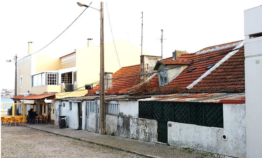
Rua Cândido dos Reis. Predominância de edifícios devolutos e em mau estado de conservação. Fotografia da autora. 2019.
