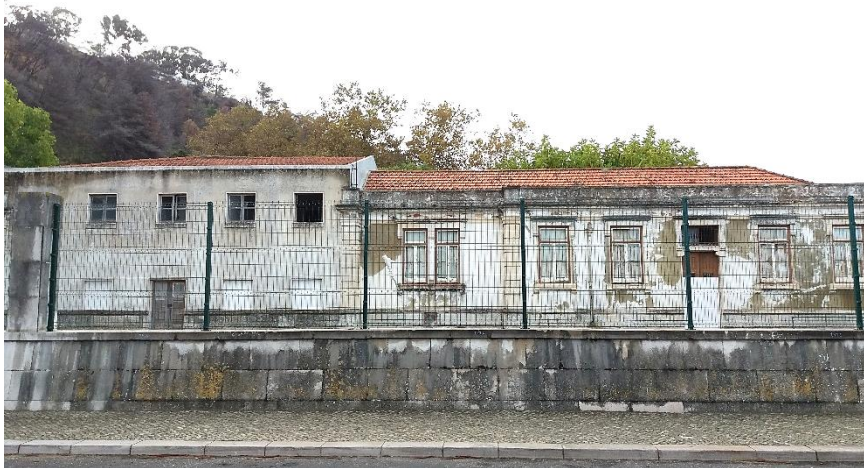
Muros que cercam a entrada no recinto do Presídio. Fachadas dos edifícios 1 e 2. Fotografia da autora. 2019.
