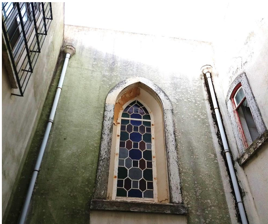
Janela de vitral da Igreja. Vista a partir do pátio interior do edifício 6. Fotografia da autora. 2019.
