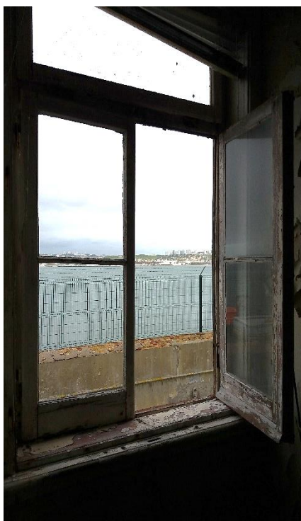
(da direita para a esquerda). Sala e vista do edifício 6. Fotografias da autora. 2019.
