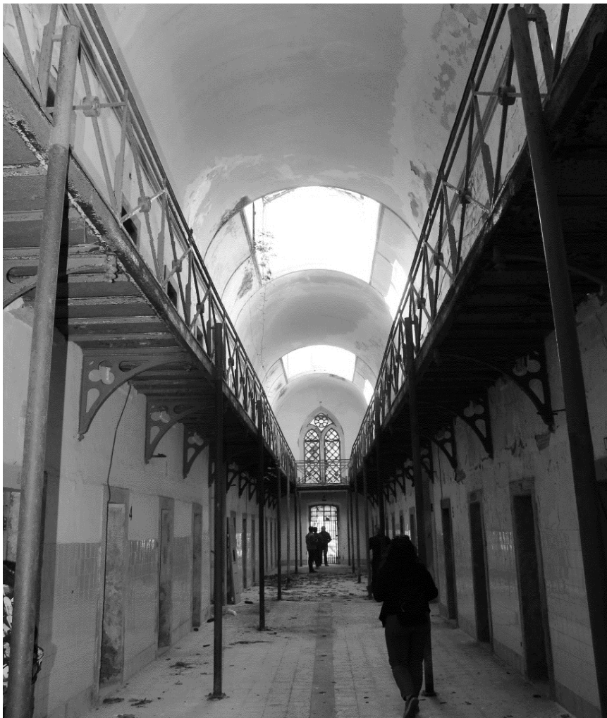
Fig. 17. Edifício das Celas do antigo Presídio. Fotografia da Autora. 2019.
