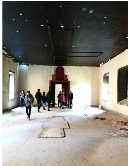
(da esquerda para a direita). Escada em ferro de acesso ao piso 1 do edifício 4 e salão acessível através dela. Fotografia da autora. 2019
