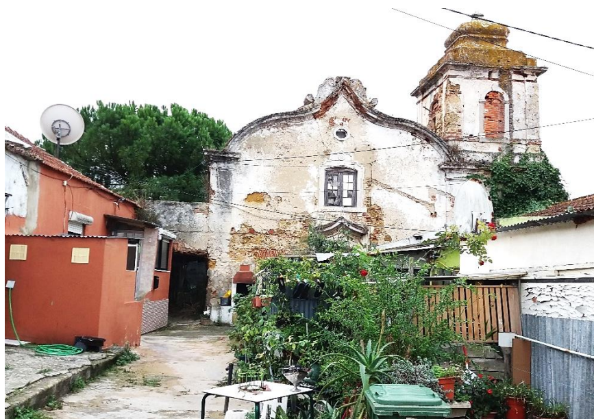
Ruína da Capela de Nossa Senhora da Conceição, rua Guedes Coelho. Fotografia da autora. 2019.
