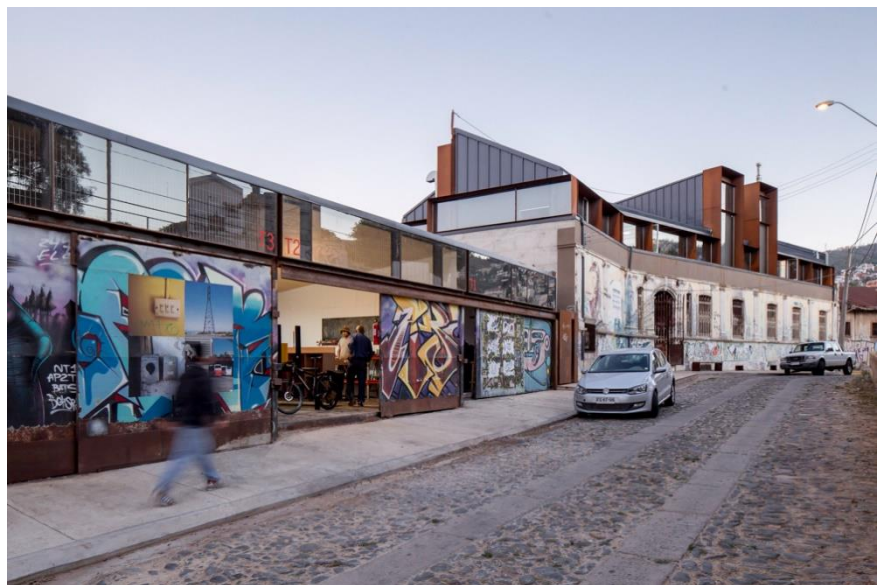
Fig.76. Dinamarca 399. Intervenção na fachada principal. Fotografia de Aryeh Kornfeld.
