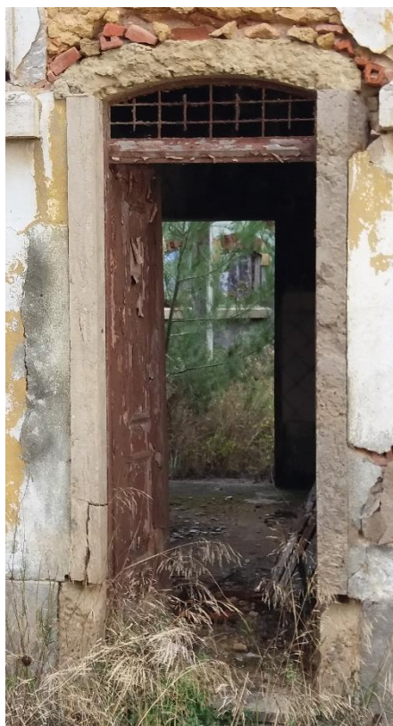
Fig.44. e Fig. 45. Portas e caixilhari- as em madeira dos edifícios do Presídio. Descascamento da tinta em grandes extensões. Fotografias da autora. 2019.
