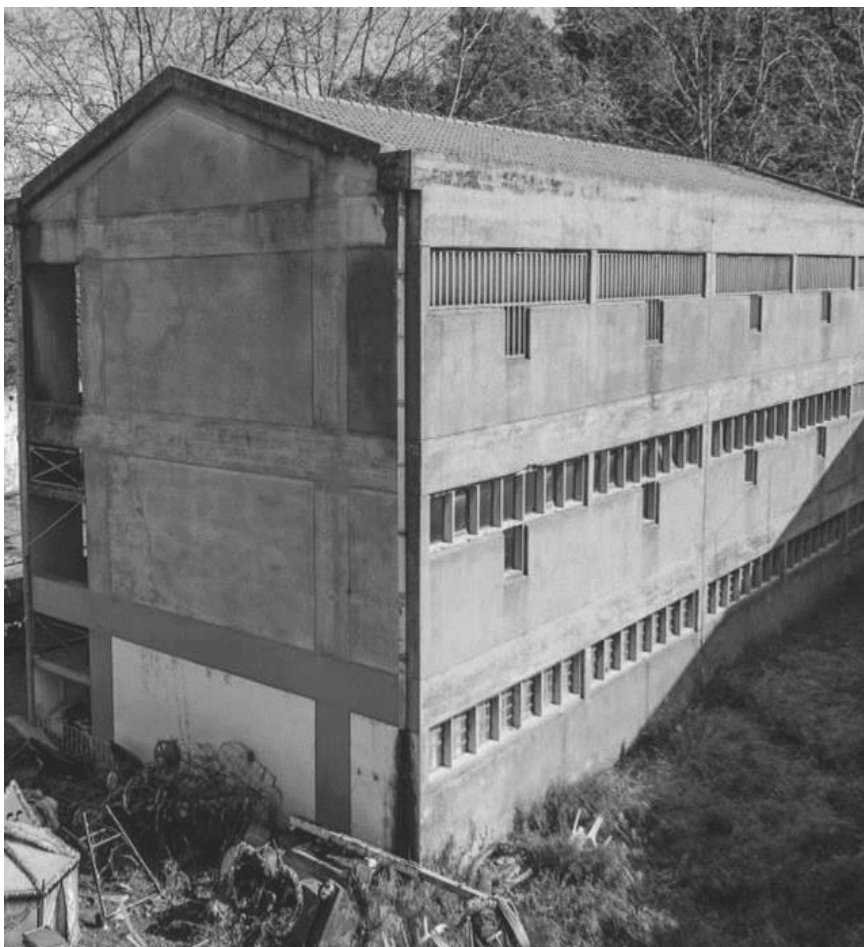
Fig.26. Fachada Sul do edifício 3. Autor desconhecido.
