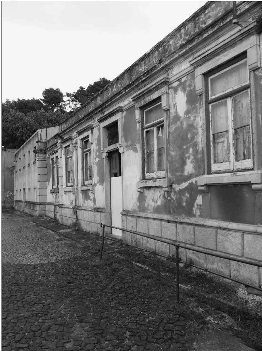
Fig.24. Fachadas principais dos edifícios 1 e 2. Fotografia da autora. 2019.
