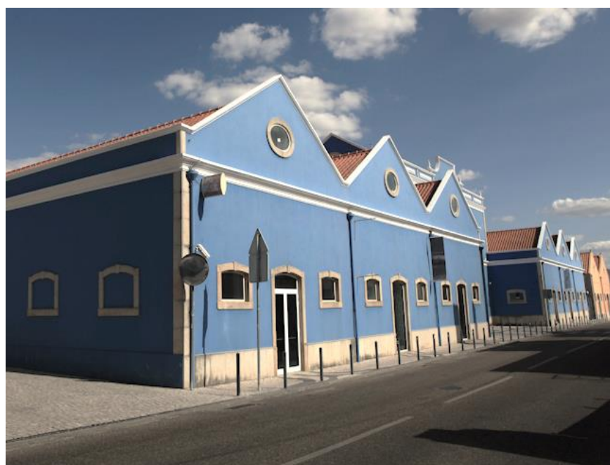
Fig.66. Centro de Artes e Cultura de Ponte de Sor. Intervenção no exterior. Fotografia de António Bracons.
