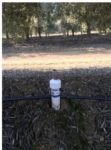
Figura 9 Sonda de sucção instalada.
