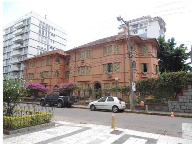
Figura 40- Foto Atual Edifício João Ibañes
