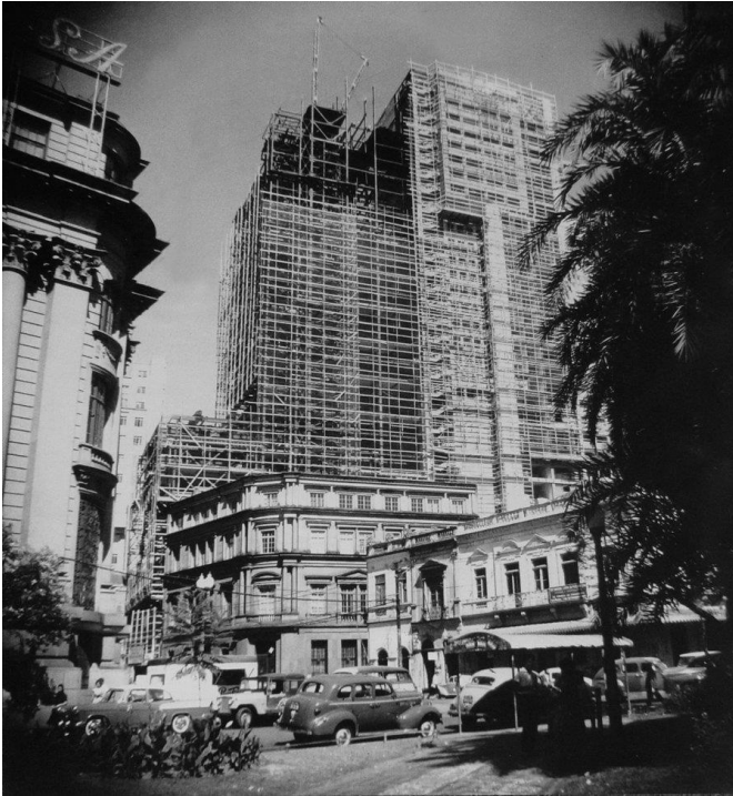
Figura 9- Construção Ed. Santa Cruz
