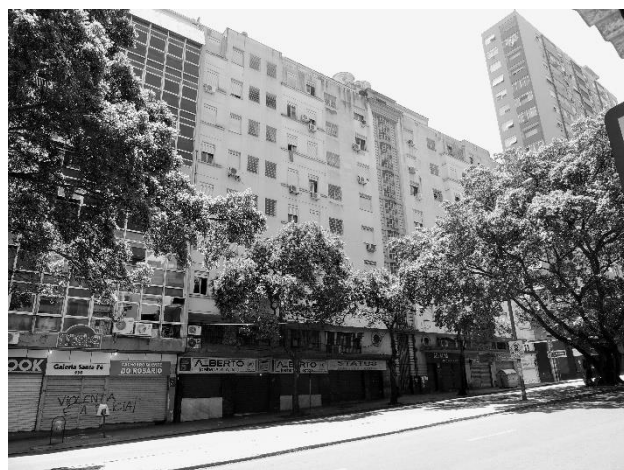
Figura 39- Foto Atual Edifício João Agostini
