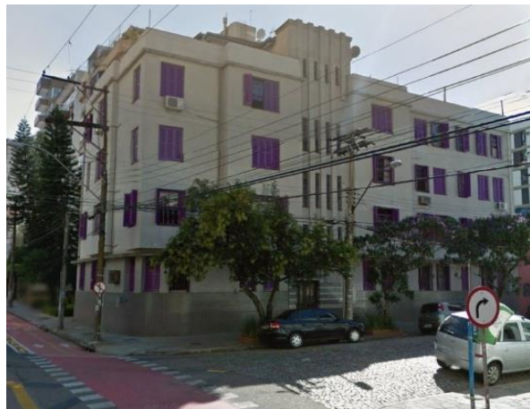
Figura 38- Foto Atual Edifício Cypriano Micheleto
