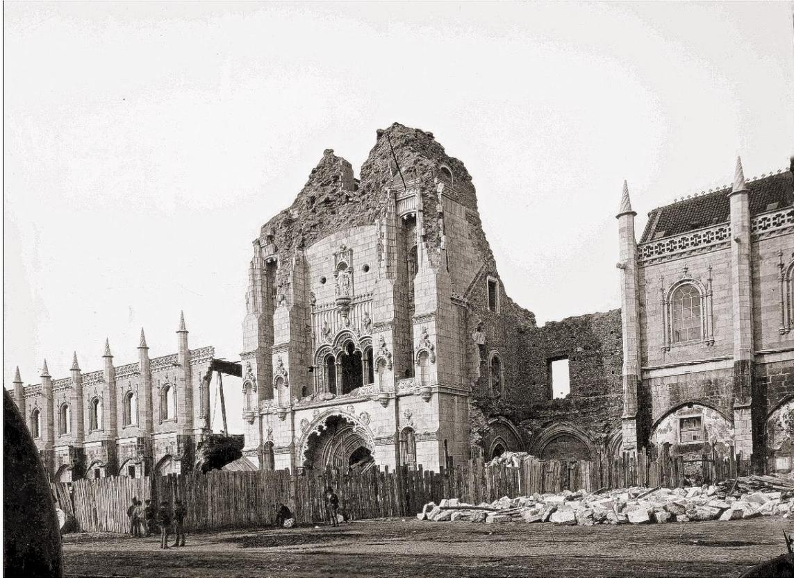
**Figura 2** Destroços causados pelo colapso do corpo central do Mosteiro dos Jerónimos (fotografia de Cinatti e Rambois, Arquivo Fotográfico Municipal de Lisboa, 1878)
