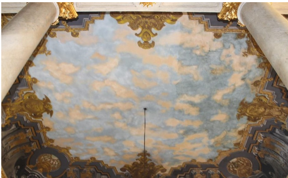
Figura 31 Teto da galeria nobre. Fonte própria
