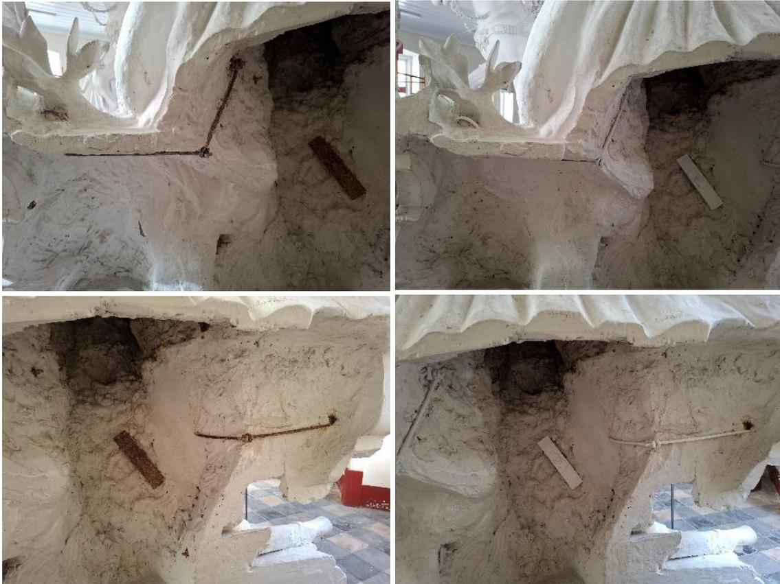
*Figura 40 Colocação da tinta antiferrugem nos metais limpos*
