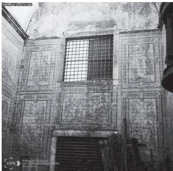
Fotografia da parede fundeira do corpo da igreja de Bom Jesus de Monforte à data da demolição (1946), vendo-se parte dos azulejos (c. 1749) com os Milagres da Rainha Santa Isabel .
