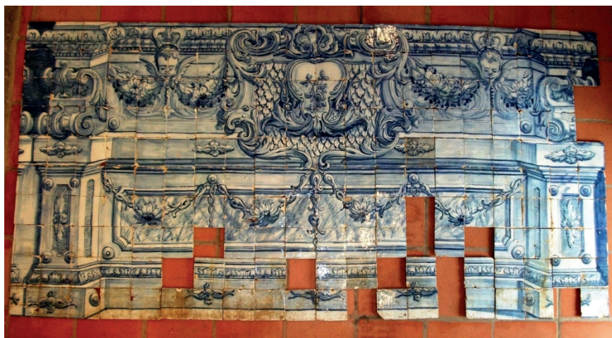
Fig. n.º 11 — Aspecto de pedestal (Painel n.º 22).
