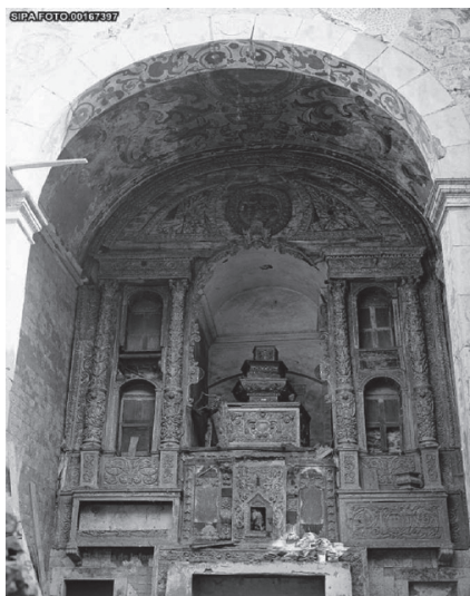
A capela-mor da igreja de Bom Jesus de Monforte em fase de demolição iminente (foto do arquivo SIPA/DGEMN, foto n.º 00167397, de 1946).
