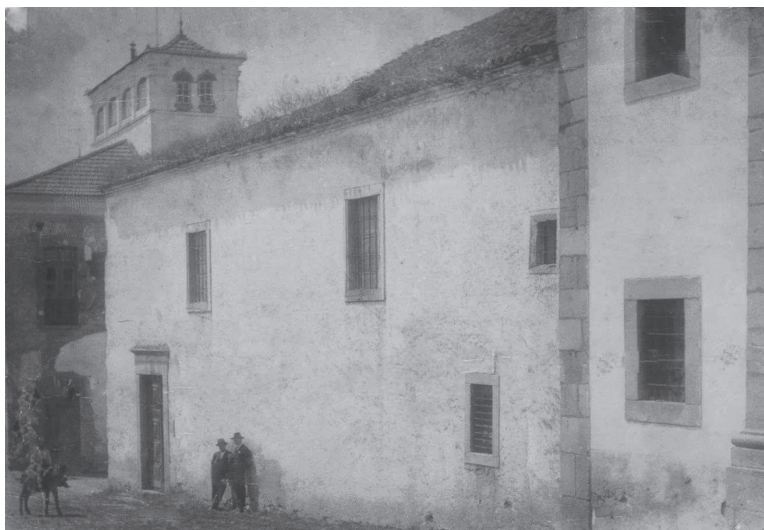
A Igreja do Convento do Bom Jesus de Monforte após a demolição dos coros.
