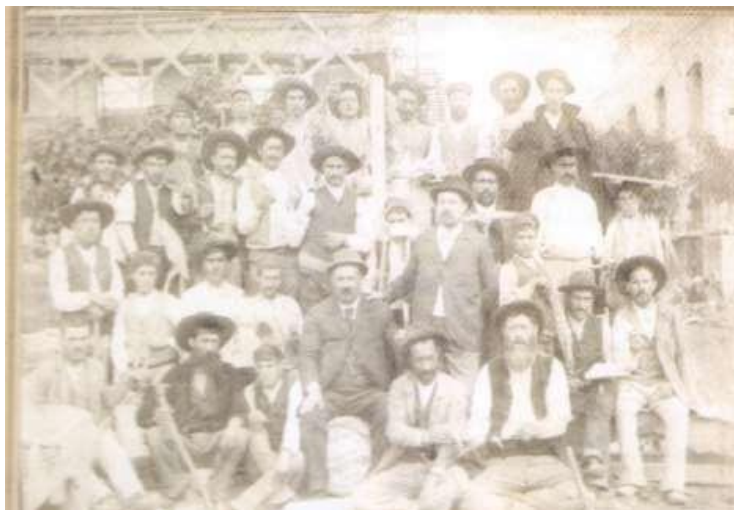
Figura 24: Os construtores do Aquário Vasco da Gama com um grupo de trabalhadores em 1896. Fonte: A Casa Grande do Mar .
